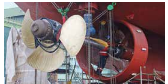
Bestandspflege: Wartungsarbeiten bei Strela Shiprepair Propellererneuerung kostet Geld, spart aber auch ein
